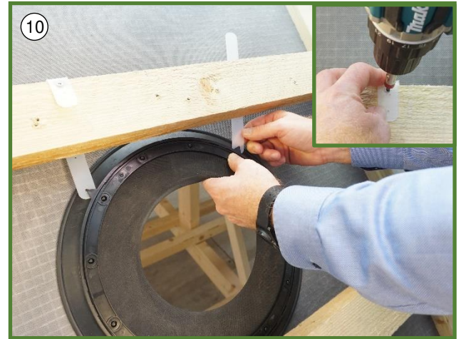
10 Monter stropper i montagehanke og fastgør til lægte.
