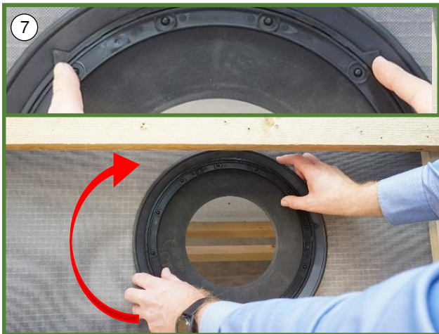
7 Drej basering med uret indtil de to montagehanke vender op ad mod tagrykken.
